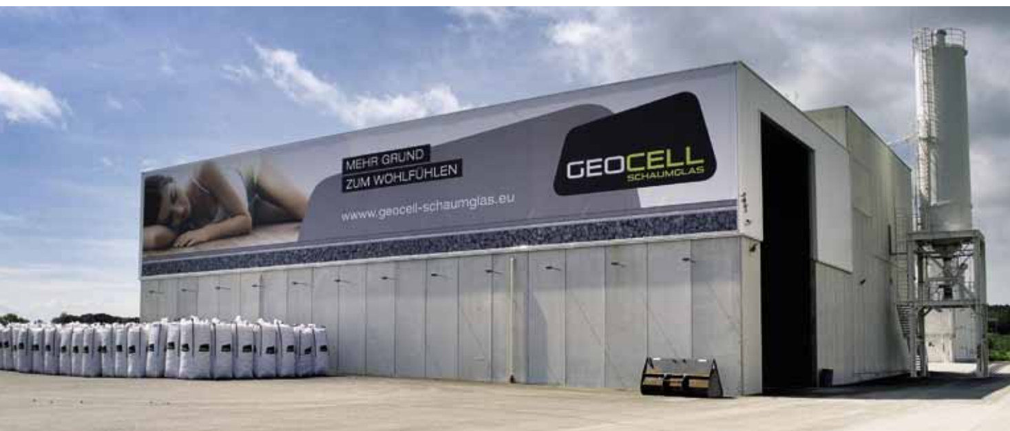
Главный подрядчик VT-Wolfgang Binder доставляет оборудование GEOCELL для производства стеклянной муки (Австрия)
